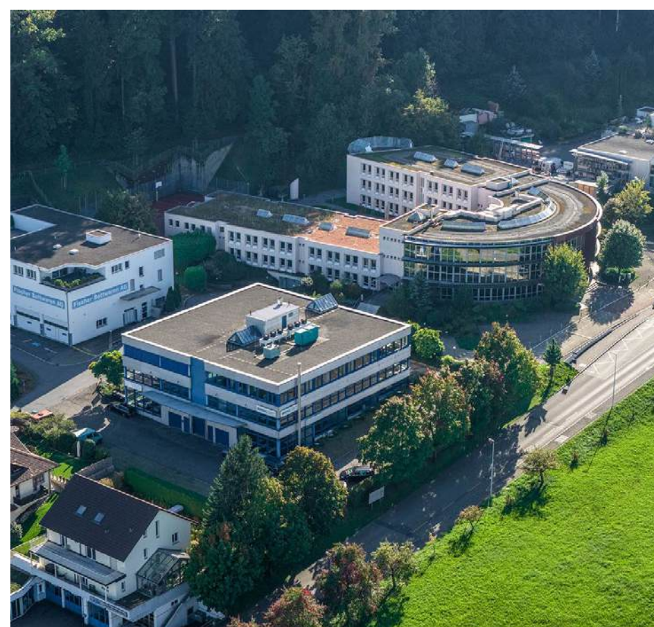
Gebäude mit blauen Fensterrahmen: Unterrichtsräume im UG und EG Gebäude in Hufeisenform: Hauptgebäude Kantonsschule Zimmerberg
