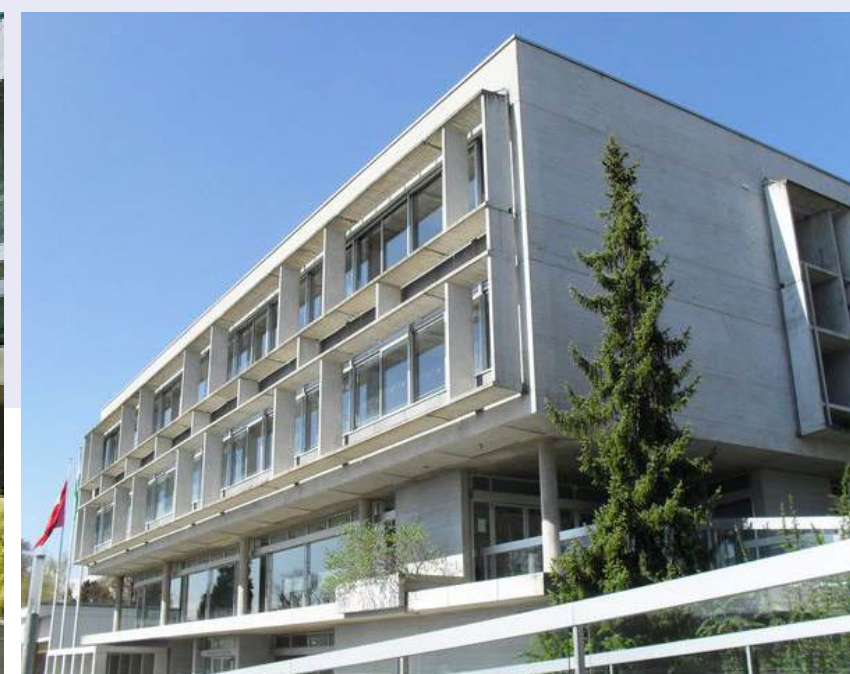
Hauptgebäude der Kantonsschule Rychenberg
