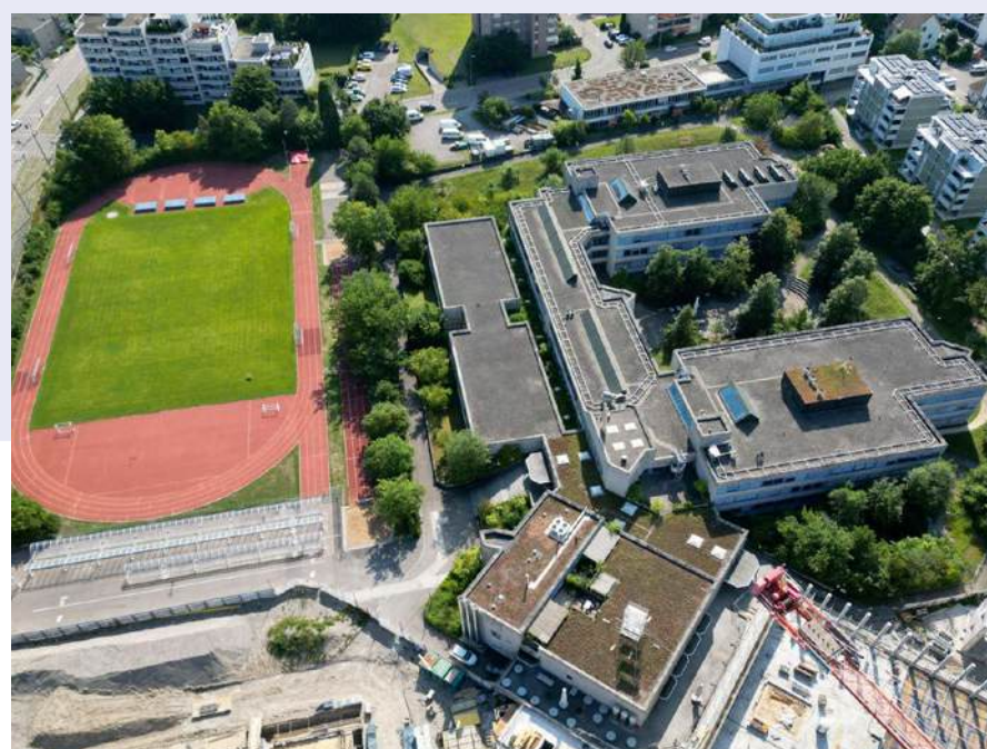
Hauptgebäude der Kantonsschule Limmattal (Trakte A–D)
