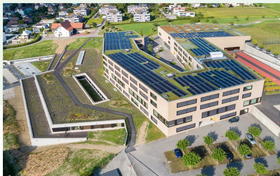
GyB en vue aérienne
