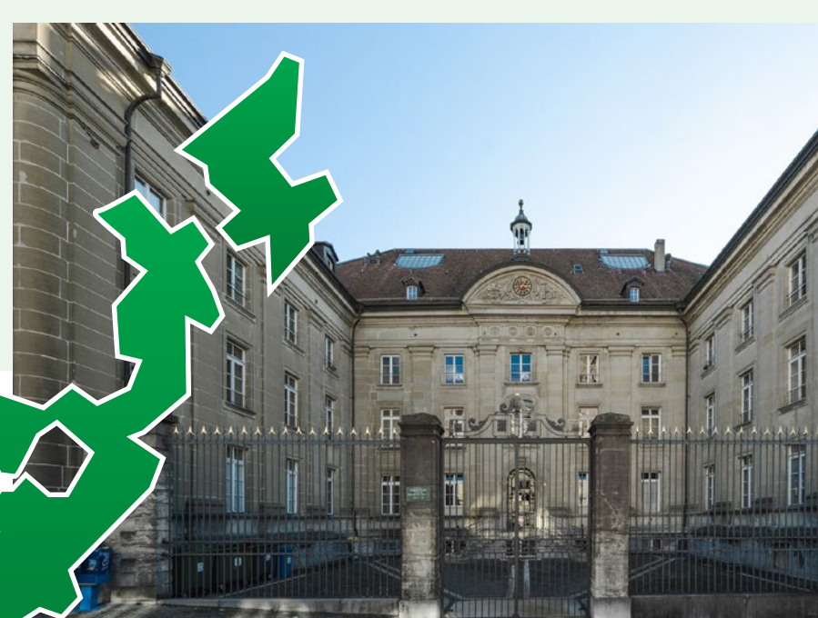
Gymnase de La Cité Bâtiment de la Mercerie, âge bâtiment : 1771
