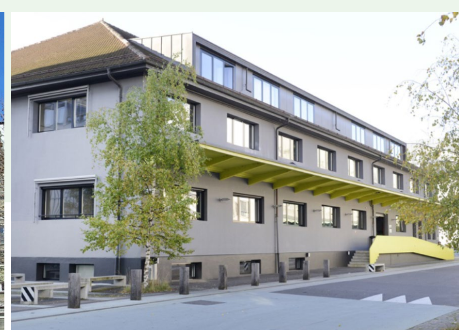
Gymnase du Bugnon site de Sévelin
