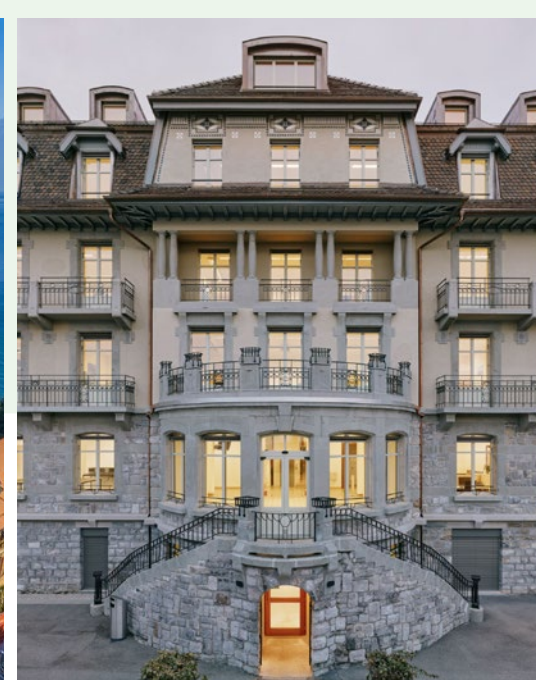
Bâtiment A : l'un des trois bâtiments du site, offrant une vue sur le lac Léman.
