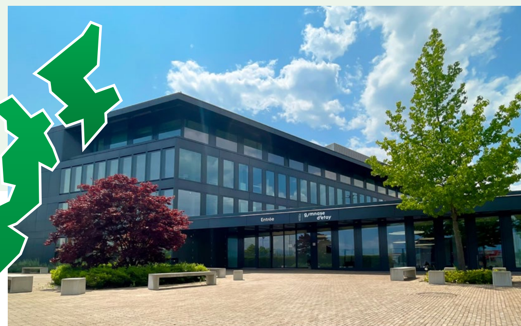
Le gymnase d'Etoy (entrée)
